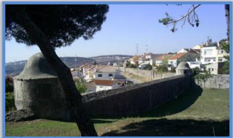
Aquedutos: Olival do Santíssimo e Poço da Bomba
